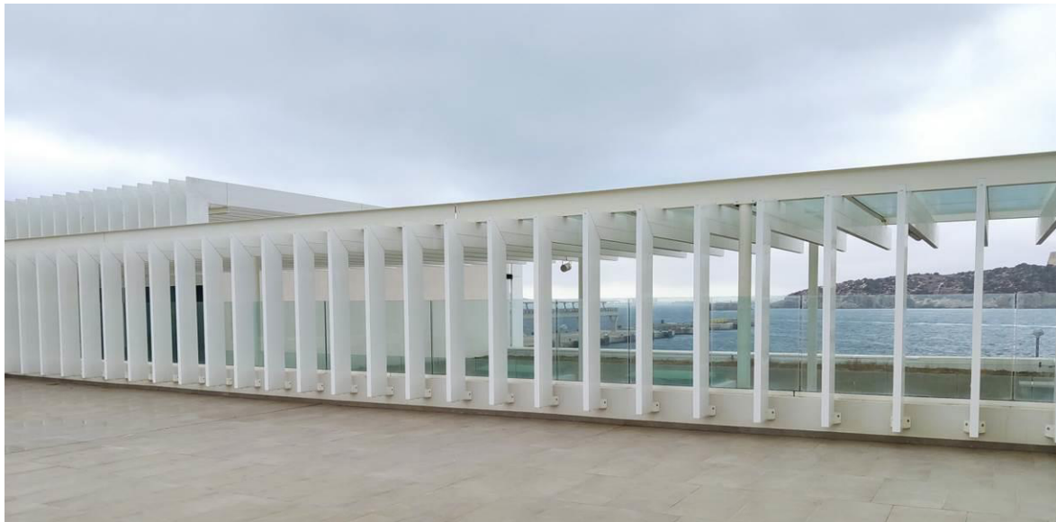
Figura 6. Lamas verticales existentes en pasarela peatonal
