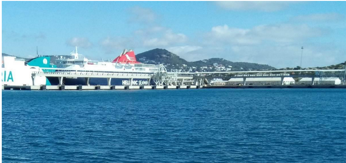
Figura 15. Perspectiva N°2 – Estado inicial
