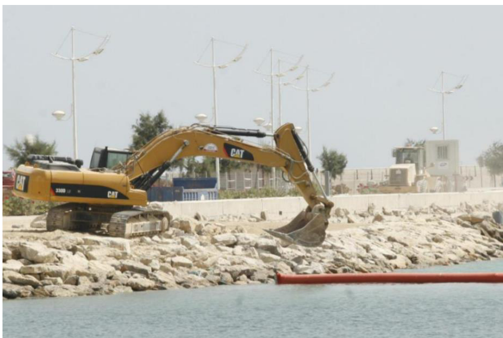
Figura 53 Ejemplo de uso de barrera antiturbidez en obras marítimas.
