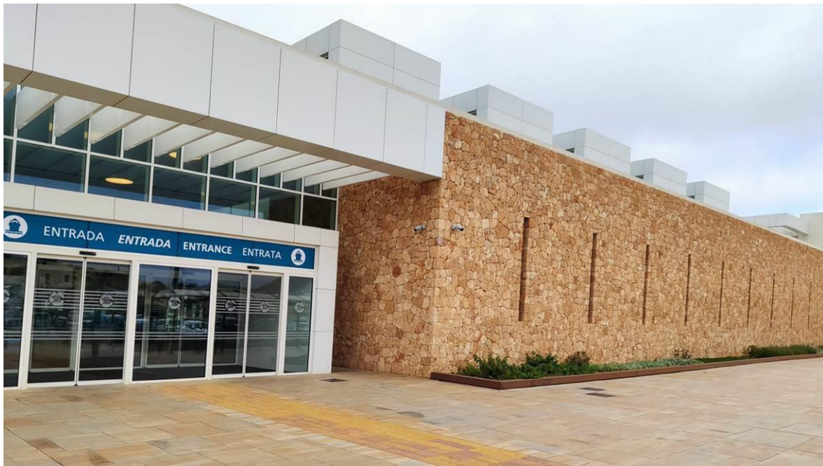
Figura 7. Estación Marítima existente. Materiales
