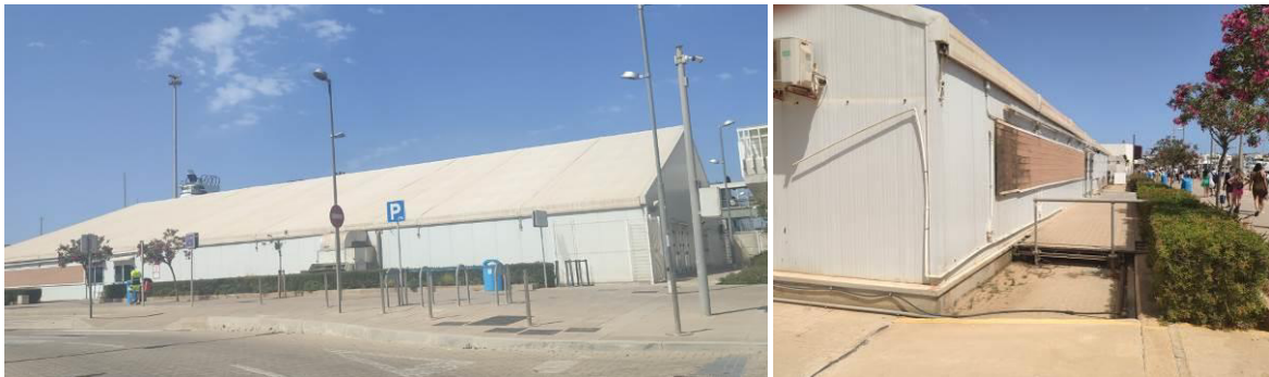
Figura 8. Carpas existentes. Estado actual
