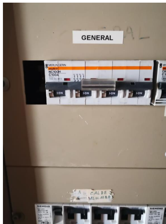
Figura 2. Interruptor general de 100A trifásico
