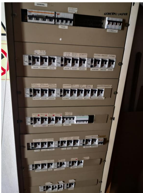
Figura 1. Cuadro de protecciones principal
