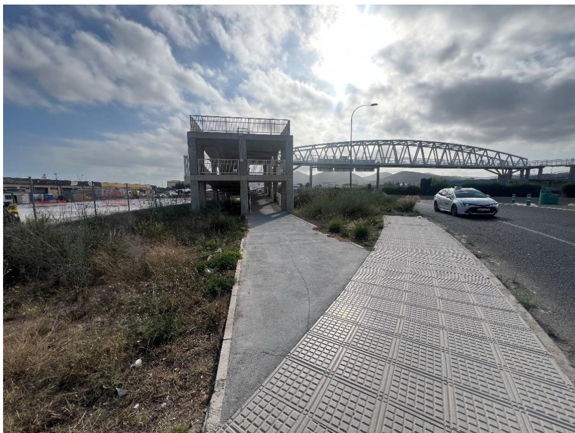
Pasarela Es Gorg que conecta Eivissa con Puig d'en Valls
